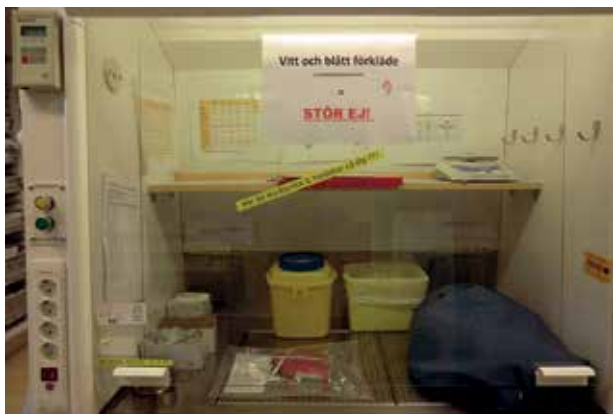
Figur 8. Illustration över plats för iordningställande av läkemedel på dragbänk för att kunna minska risken för arbetsmiljöpåverkan på personal.
